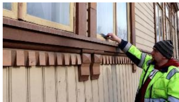
Korjausklänikka-hankkeen tapahtumassa maaliskuussa 2020 rakennuskonservaattori Niko Palonen teki Heinolan WPK-talolla korjaustarveselvitystä, jota yleisö sai seurata. Kuva: Reetta Nousiainen.
